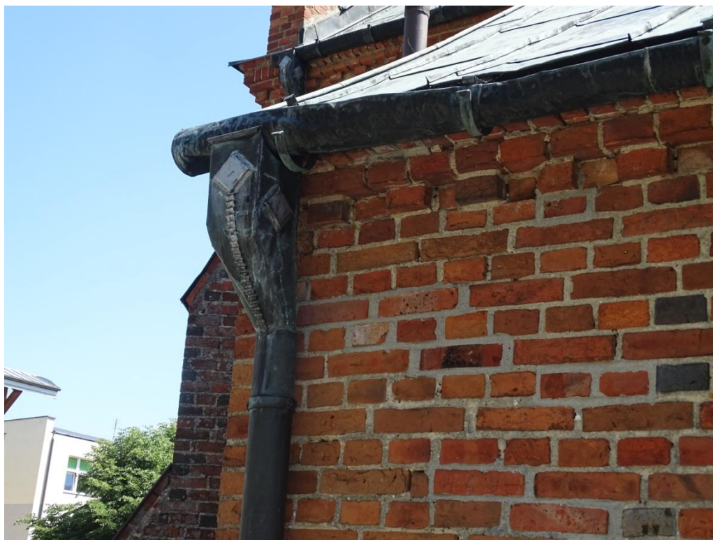
Stan obróbek blacharskich, rynna w złym stanie technicznym, wygięcia spowodowane napieraniem pokrywy śniegowej w miesiącach zimowych.
