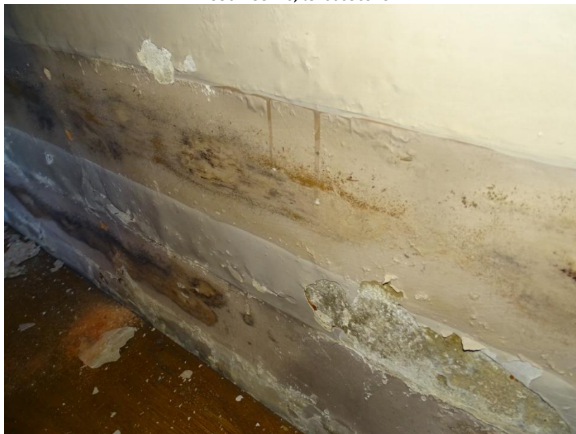
Stan zachowania obszaru ściany wskazanego na termogramie powyżej. Wilgoć spowodowała dezintegrację tynku, odpajanie warstw malarskich oraz nasiloną korozję mikrobiologiczną
