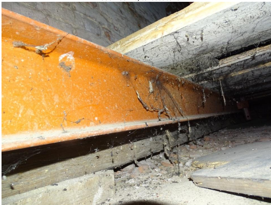
Konstrukcja stalowej kratownicy więźby dachowej –fragment
