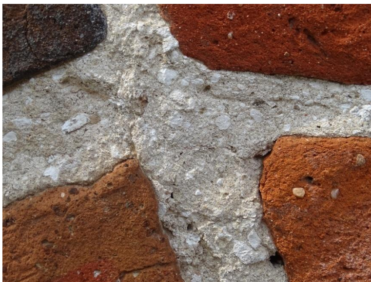
Spoina wapienna z kruszywem kwarcowo- wapiennym i cegła gotycka na ścianie kruchty.
