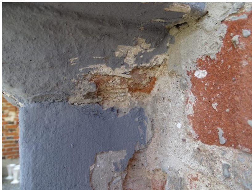
Odkrywka pokazująca sposób wykonania epitaфium i wtórne warstwy tynków .
