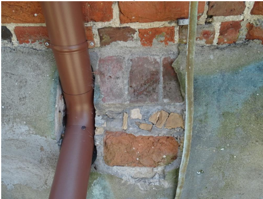
Stan zachowania cokołu pod szczelną warstwą cementowej zaprawy, widoczne zacieki na cokole o zabarwieniu zielonym , świadczące o zawilgacaniu tej partii wodą z dachu.
