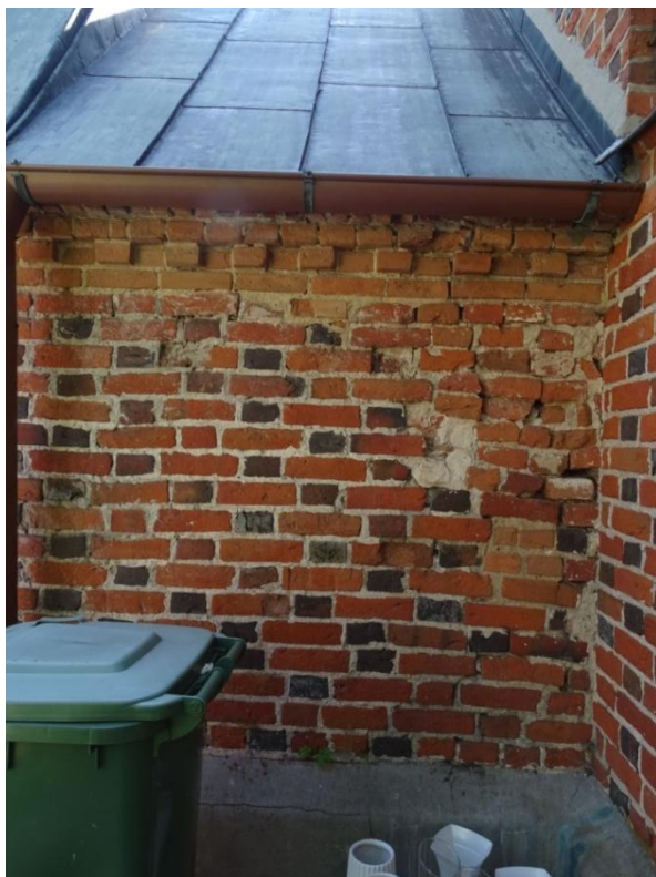
Fragment uszkodzenia wstęgu muru na ścianie kruchty
