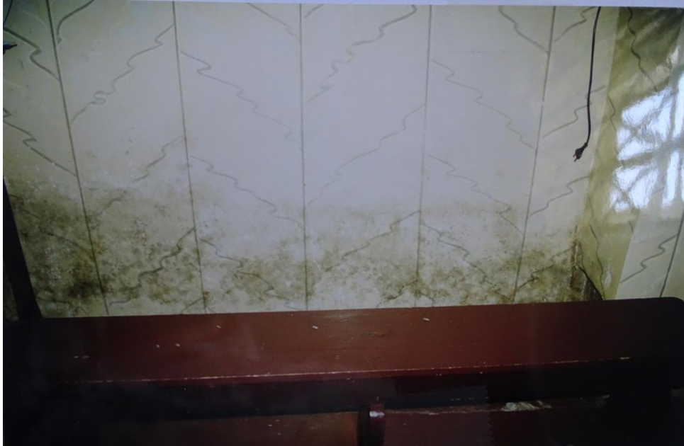
Zawilgocenie na lamperii na ścianie południowej. Stan z 1999 r. Fot. A. Bystroń –Kwiatkowska.
