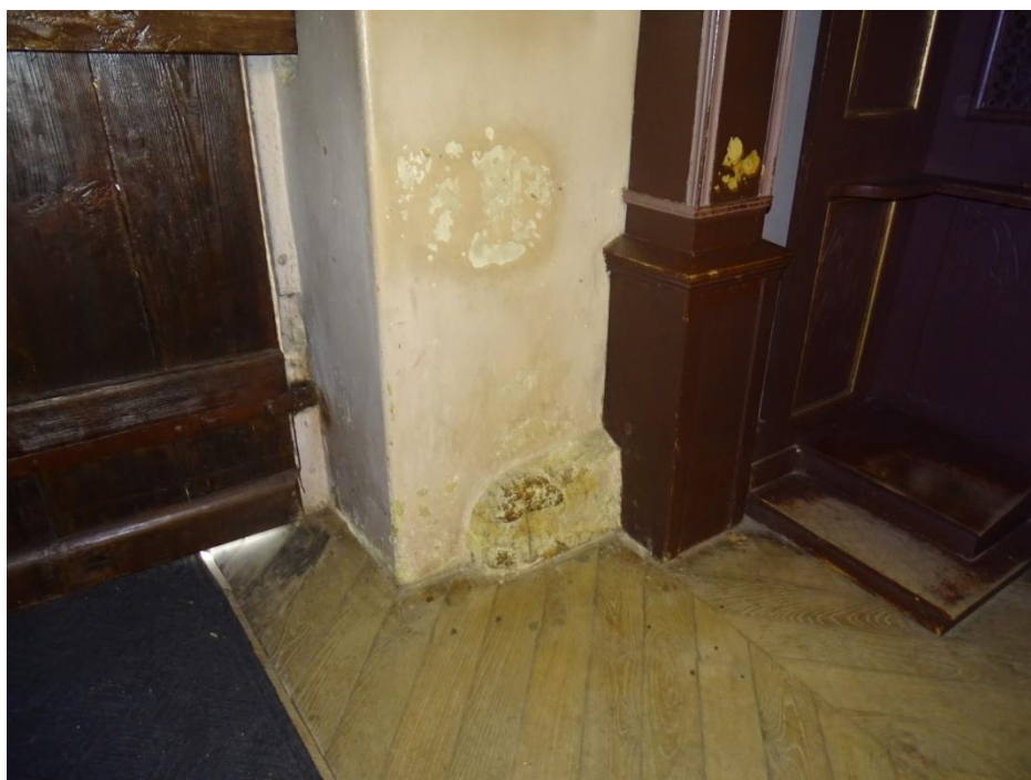
Widoczny głaz narzutowy fundamentu kościoła na zachodniej ścianie .
