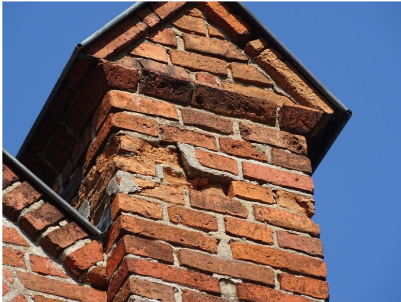
Dezintegracja wierzchnich warstw cegieł na skutek napraw niskonasąkliwą cementową spoiną.
