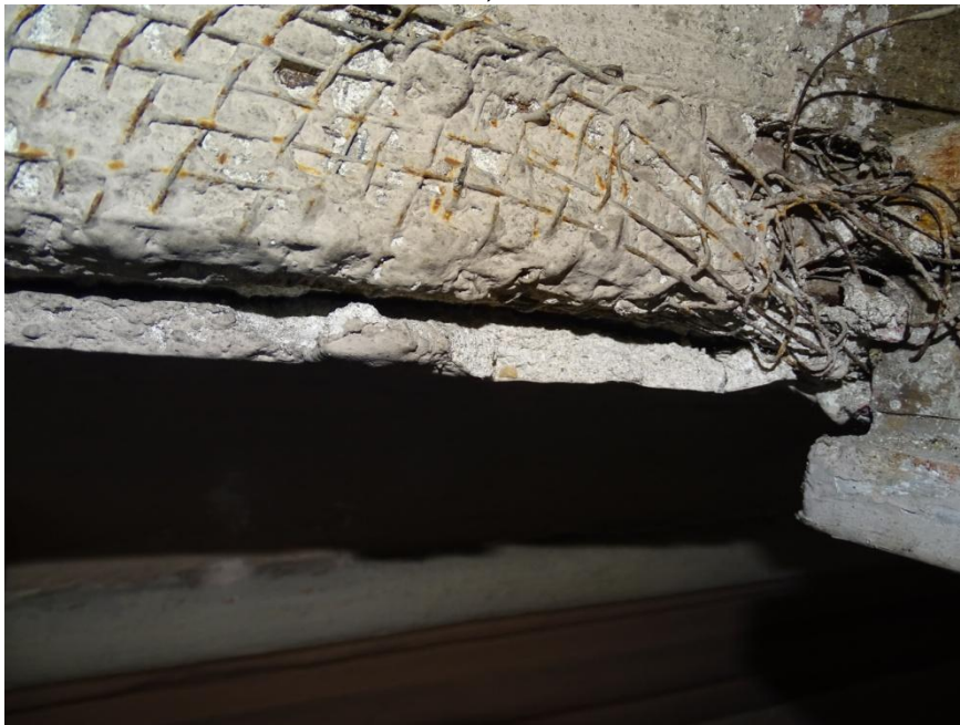
Siatka druciana na której założono tynk wapienny w 1955 roku na drewnianym stropie kościoła.
