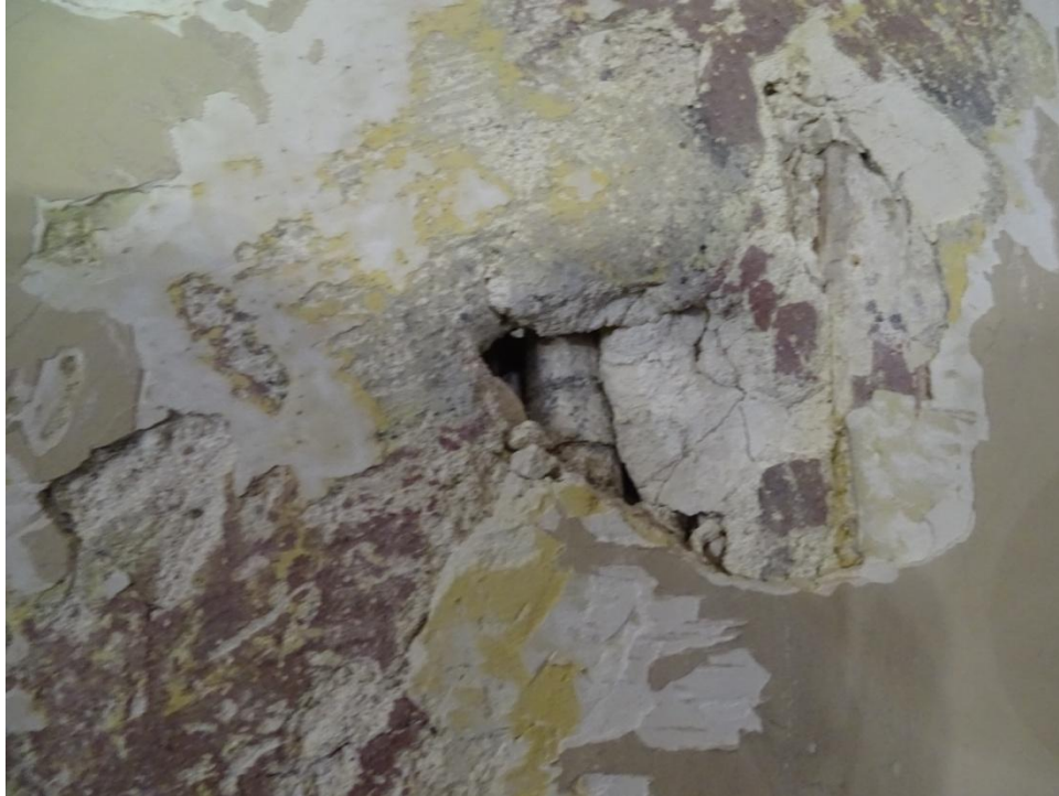
Malowidło z 1955 roku wykonano na tynku założonym wtórnie na kable elektryczne, widoczny przewód elektryczny w ścianie z lat 50 tych XX wieku.
