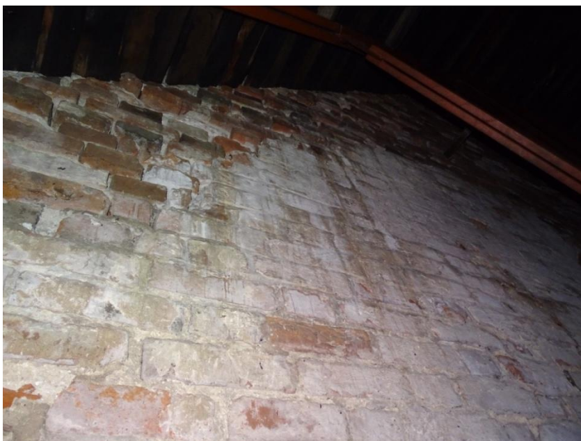
Stan zachowania szczytu zachodniego-widoczne ubytki spoiny i poluzowanie cegieł w górnej partii.
